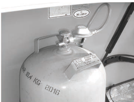
Bild 70: Gasolflaska med lågtrycksregulator och lågtrycksslang
