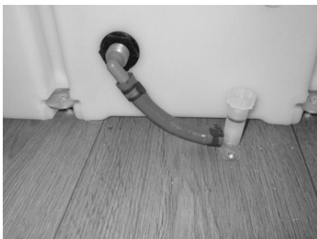
Bild 90: Avtappningsventil, exempel
