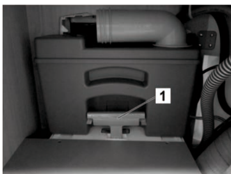
Bild 195: Fekalietank i avfallsschaktet
