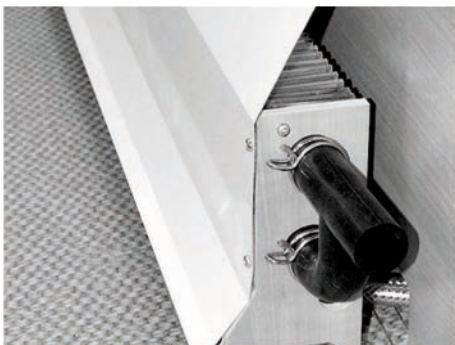
Bild 84: Konvektor med värmeledningsplåt
